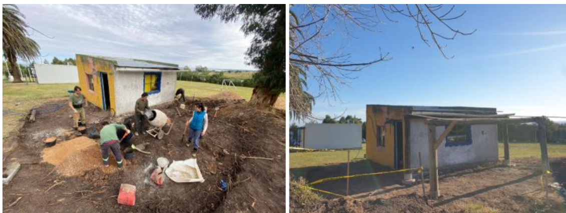
Ilustración 8 - Cimentaciones y estructura de la ampliación.
