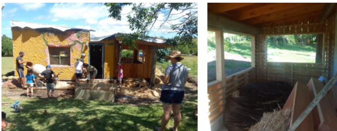
Ilustración 10 - Jornada de envarillado y llenado de muros
