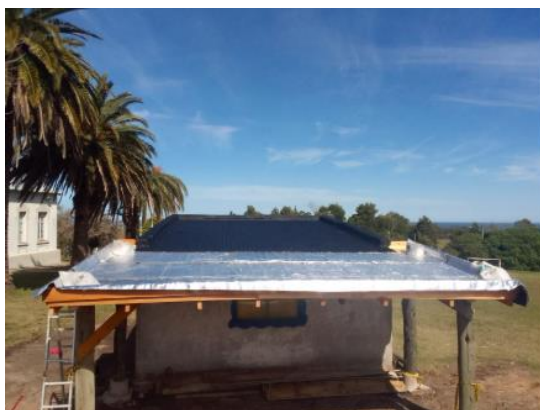
Ilustración 14 - Ejecución impermeabilización de la cubierta
