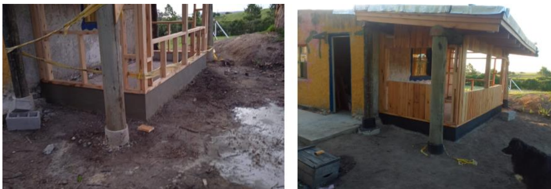
Ilustración 9 - Muros de Ampliación
