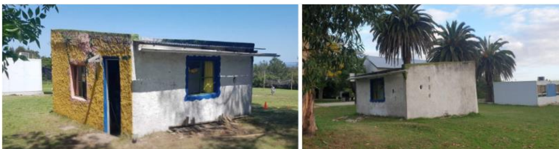
Ilustración 7 - Depósito previo a su intervención.
