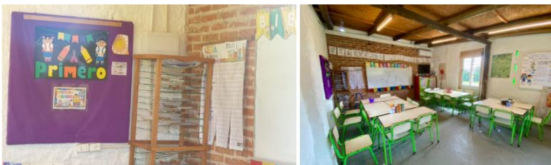
Ilustración 17 - Tablero e instalación eléctrica, lumínica y de aire acondicionado.
