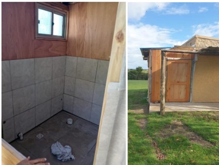
Ilustración 13 - Baño vista interior y exterior
