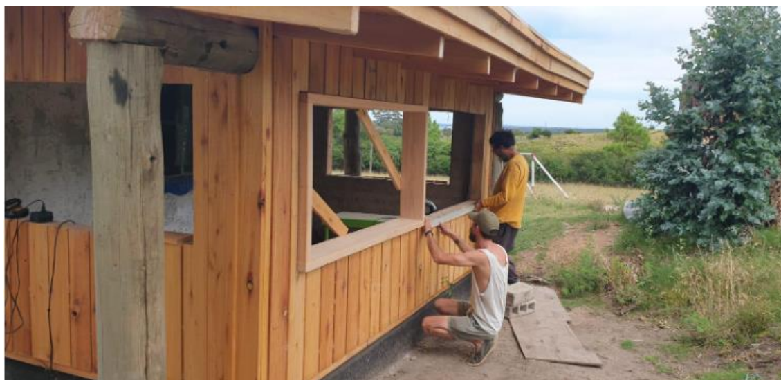
Ilustración 11 - Revestimiento exterior
