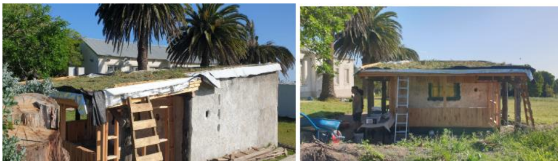
Ilustración 15 - Colocación de panes de césped y suculentas en techo vivo
