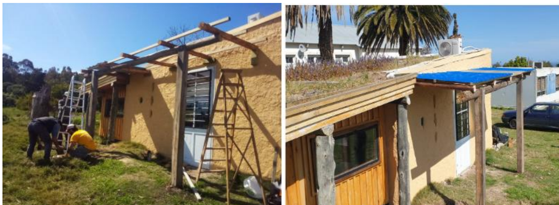
Ilustración 16 - Construcción de galería del lado oeste
