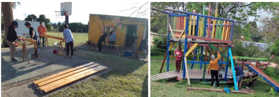
Ilustración 5 - Jornadas Comunitarias de construcción y mantenimiento de la escuela
