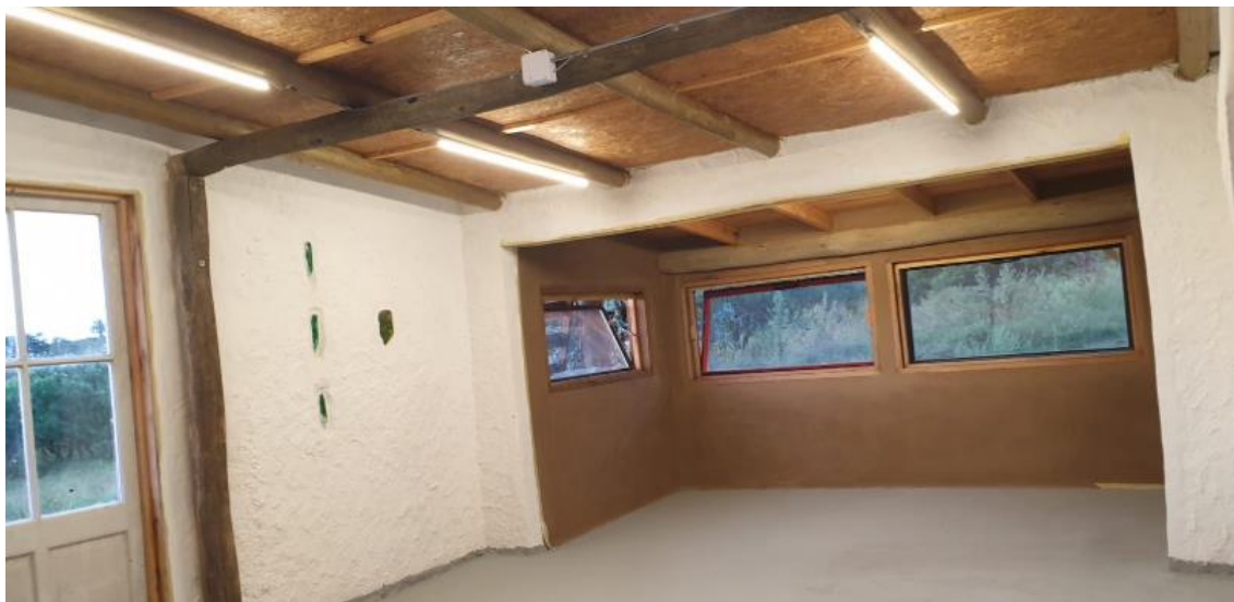
Ilustración 12 - Vista terminación revoques finos, piso y muros pintados
